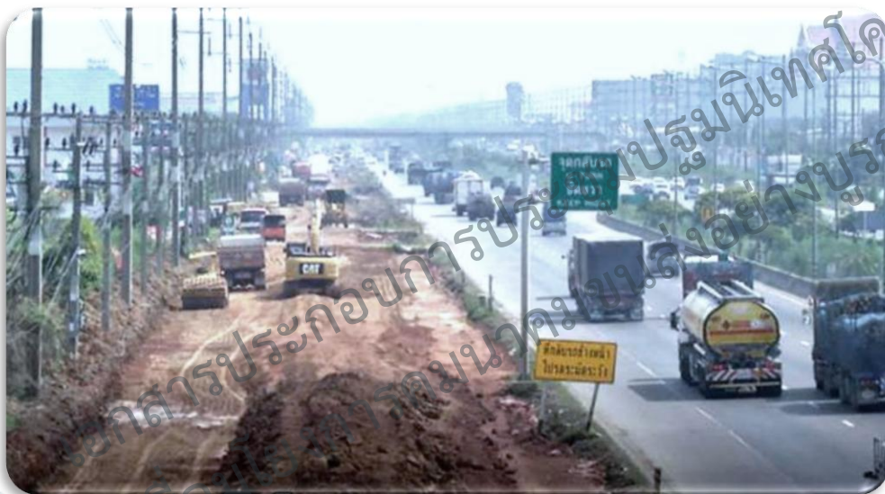
โครงการก่อสร้างเพิ่มช่องจราจร เพื่อลดความแออัดของโครงข่าย
