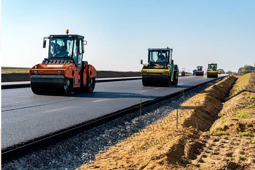
๙) โครงการบูรณะและเพิ่มประสิทธิภาพทางหลวง
