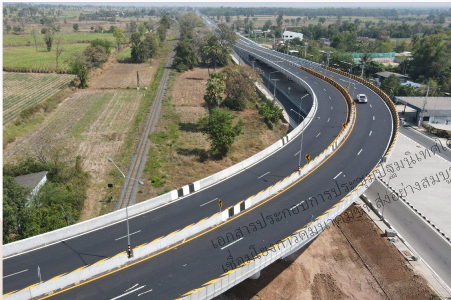
๑๑) โครงการก่อสร้างสะพานข้ามทางรถไฟ
